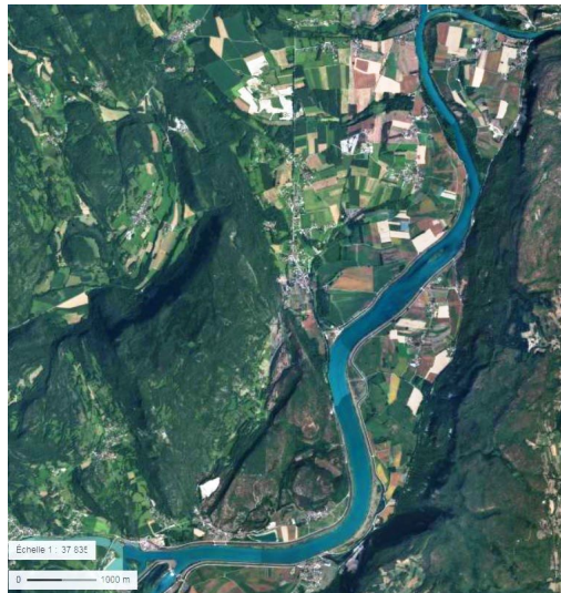
3 - Le Rhône CNR canalisé et endigué en amont du barrage de Champagneux
